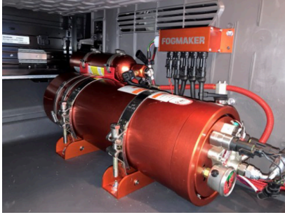
Figur 66. Plug & Play-box installerad i skyddat område
